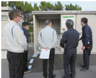
現場監査 (繊維本部)
